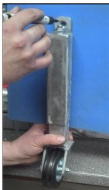
1. Anbauhöhe am eingebauten Tor festlegen. Diese bestimmt sich nach Unebenheit des Bodens und nach der gewünschten Vorspannung der Feder bzw. der Rolle.
